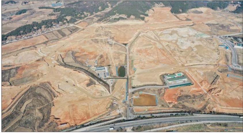
빛그린산업단지 조성공사 2공구.
