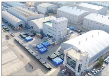
누보 울산공장 전경. /누보
