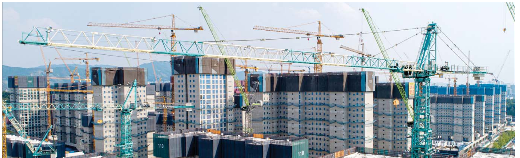
둔촌주공 재건축 타워크레인 철수
