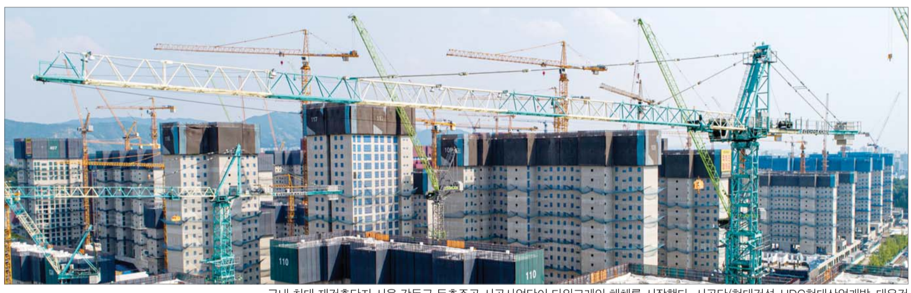
둔촌주공 재건축 타워크레인 철수
