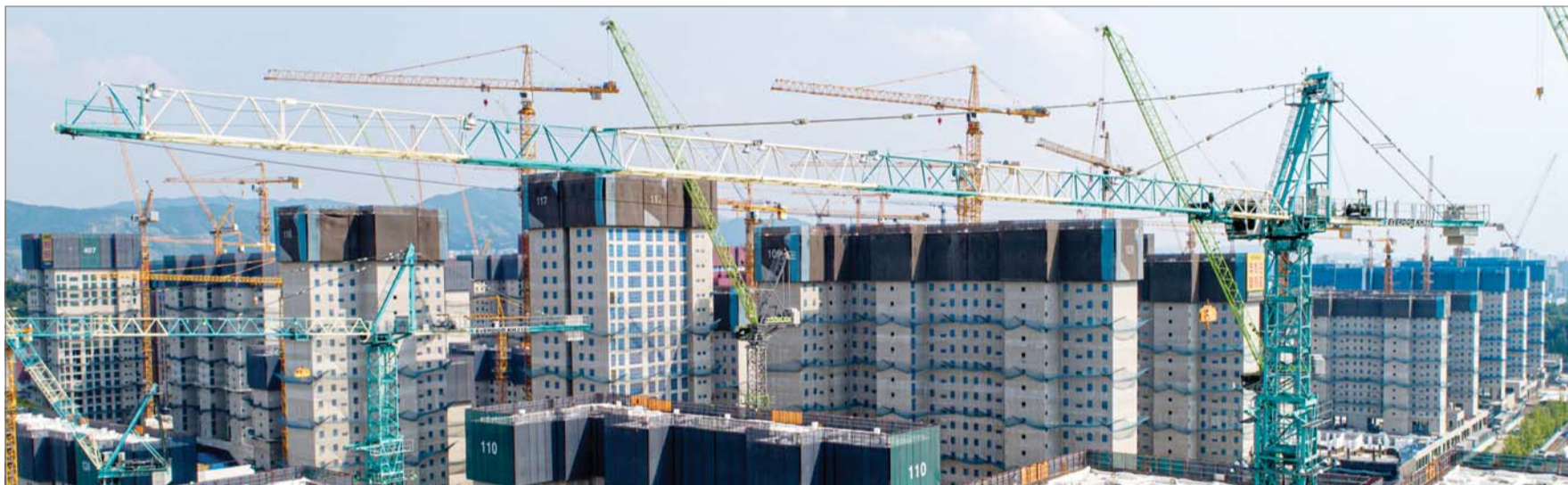
둔촌주공 재건축 타워크레인 철수
