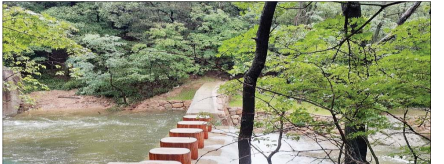
은평구 진관동 일대 사방댐 시공 현장. /서울시
