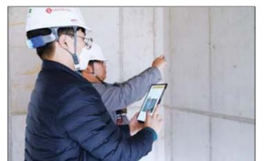
스마트폰으로 콘크리트 균열을 촬영(우측)하고 이를 태블릿PC에서 확인(좌측)하는 모습, /롯데건설
