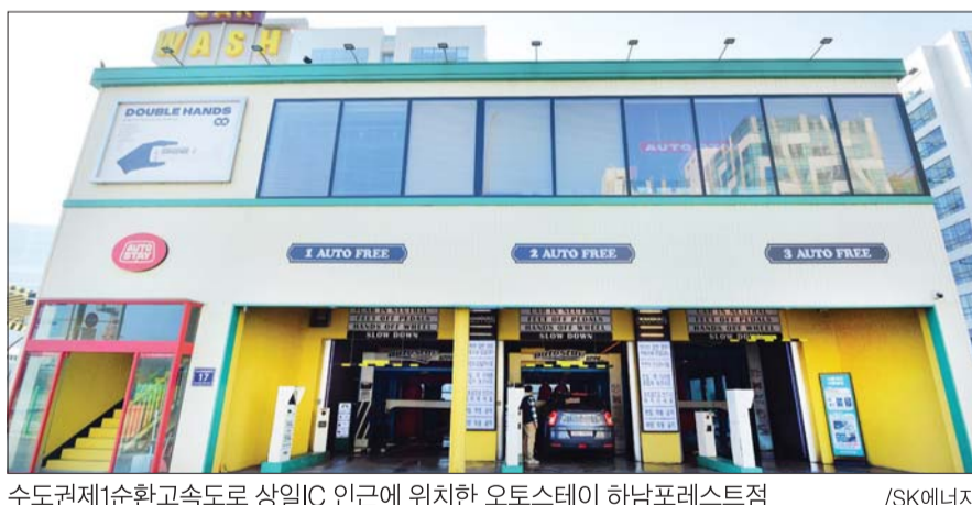
수도권제1순환고속도로 상일IC 인근에 위치한 오토스테이 하남포레스트점 /SK에너지
