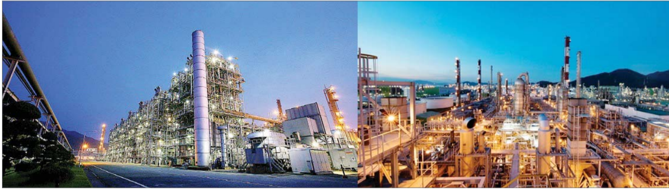
LG화학 대산공장과 롯데케미칼 여수공장 전경
