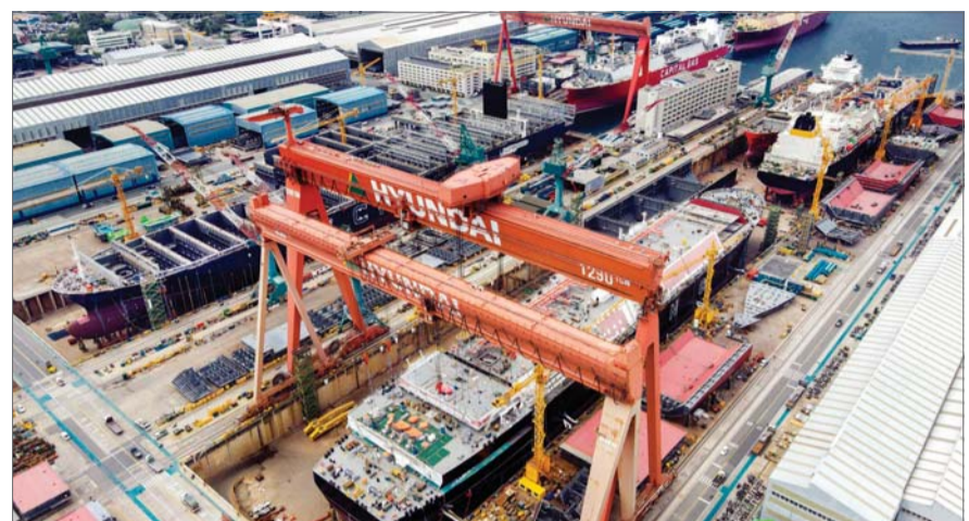
현대중공업 울산 조선소 도크 전경. 1600t 콜리엇 크레인들이 선박 구조물을 나르고 있는 모습. /현대중공업
