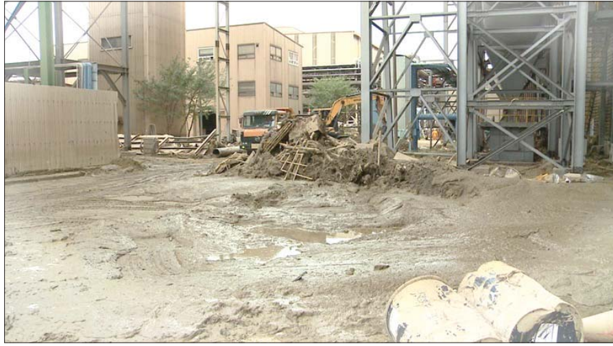
포항제철소 스테인리스 2제강공장 주변도로 복구 전(좌) 후(우) 모습.
