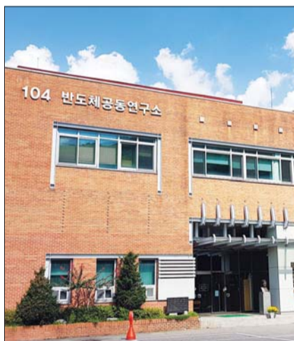
교육부가 15일 경북대와 부산대, 전남대, 충남대를 서울대 반도체공동연구소와 연계해 연결망을 구축하는 권역별 반도체공동연구소 건립 대학으로 선정했다. 사진은 서울대 반도체공동연구소 전경. /연구소 홈페이지
