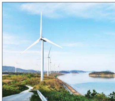
신안그린에너지 육상풍력단지 전경
