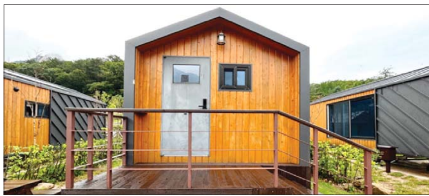
북한산국립공원 사기막 야영장 내 숙박시설 중 하나인 하우스형-카라반(20~35㎡)의 모습.
