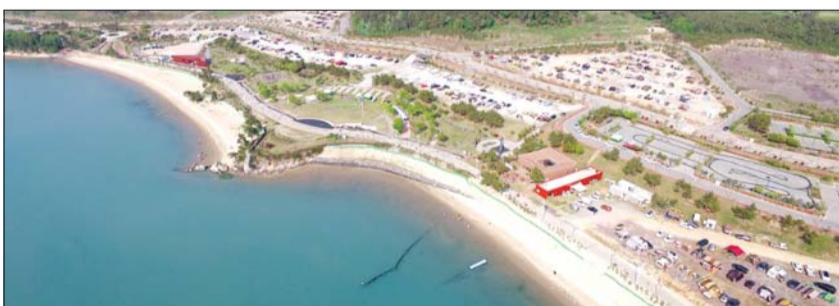
해남 오시아노 오토캠핑장 전경.
