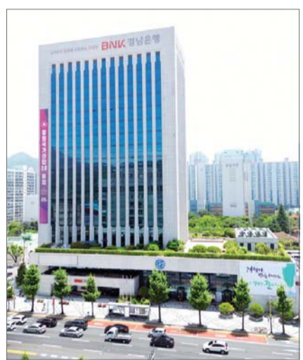
경남 창원 BNK경남은행 본사 전경. /경남은행
