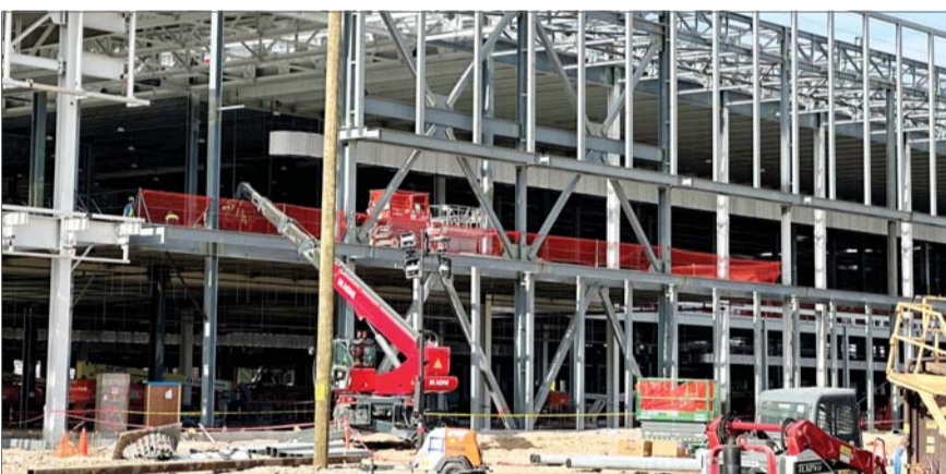
지난달 25일(현지시각) 미 조지아주 엘라벨에 현대자동차의 전기차 전용 공장 ‘현대차그룹 메타플랜트 아메리카’(HMGMA) 공사가 진행되고 있다. HMGMA는 메타플랜트 착공 1주년을 맞아 공사 진행률을 공개하면서 생산 시설 기초 공사를 99.9% 완료했다고 밝혔다. AP/뉴시스
