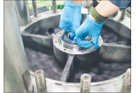
평택기지 LNG 펌프에 초저온 베어링을 설치하는 모습 /가스공사
