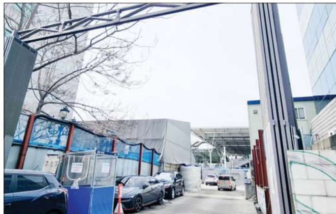
수도권 광역급행철도(GTX)-A 공사 현장 모습.
