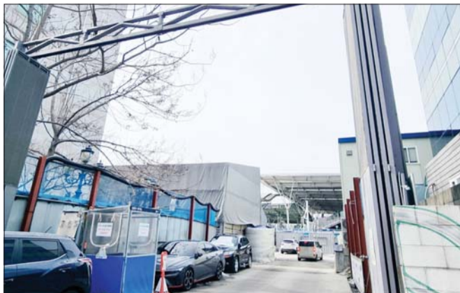
수도권 광역급행철도(GTX)-A 공사 현장 모습.
