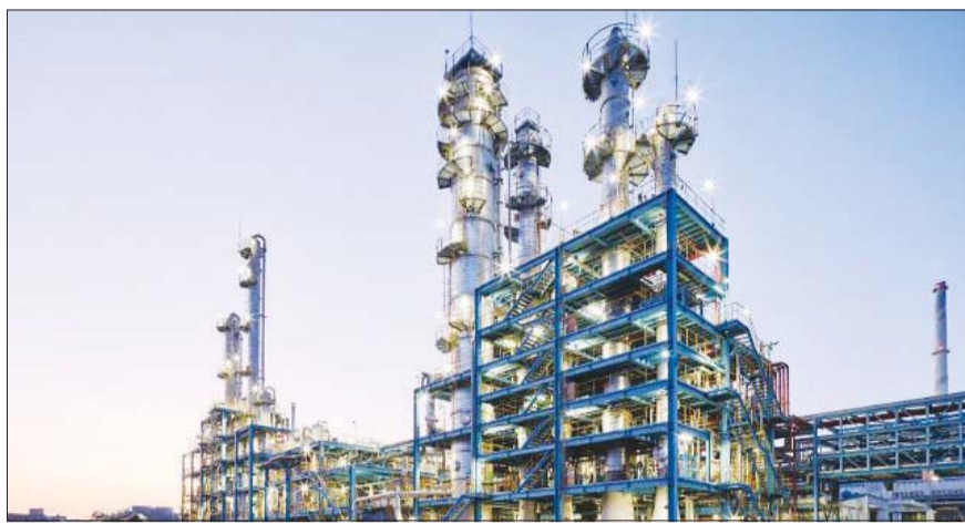
롯데정밀화학 염소계열 공장.
