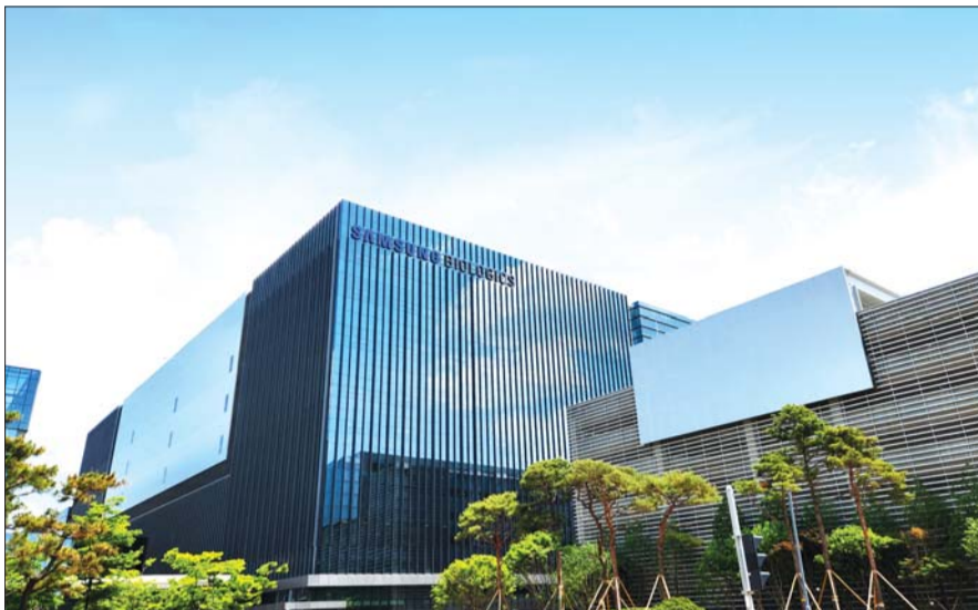
삼성바이오로직스 제4공장 전경.
