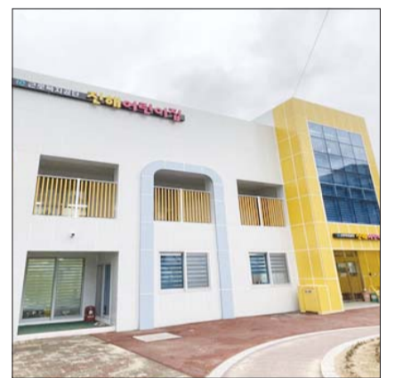
화재안전성능보강공사를 완료한 근로복지공단 직영 진해어린이집 전경. /근로복지공단
