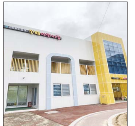
화재안전성능보강공사를 완료한 근로복지공단 직영 진해어린이집 전경. /근로복지공단
