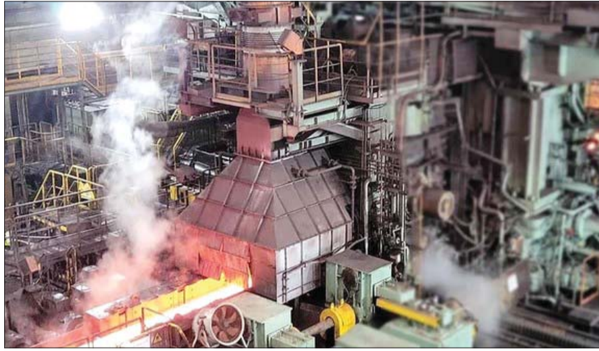
포스코 포항제철소 1열연공장 내부 전경
