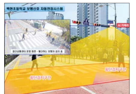
용인시 기흥구 백현초등학교 앞에 설치된 보행 신호 자동 연장시스템 /용인시
