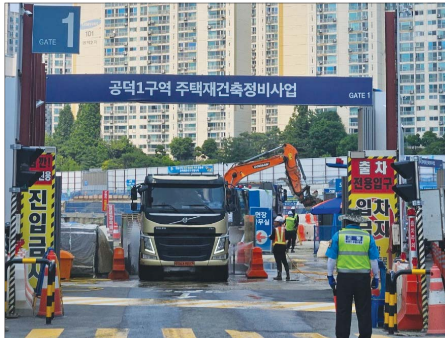
서울 마포구 공덕1구역 주택재건축 정비사업을 통해 들어서는 ‘마포자이힐스테이트 라첼스’ 공사 현장.
