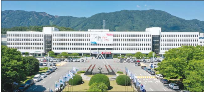
경남도청 전경. /경남도
