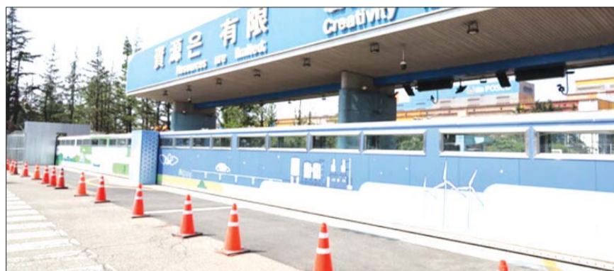
포스코 포항제철소 외곽에 설치된 차수벽.
