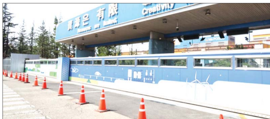
포스코 포항제철소 외곽에 설치된 차수벽.
