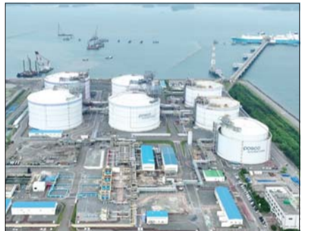
포스코인터내셔널의 광양 제1LNG터미널 전경.
