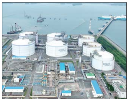
포스코인터내셔널의 광양 제1LNG터미널 전경.
