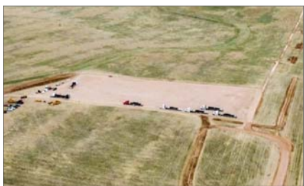
한화큐셀이 미국 콜로라도주에 건설 중인 태양광 발전사업 부지 /한화큐셀
