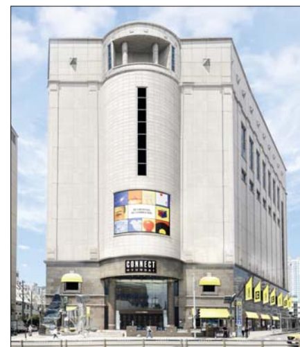
현대백화점 커넥트현대 전경. /현대백화점
