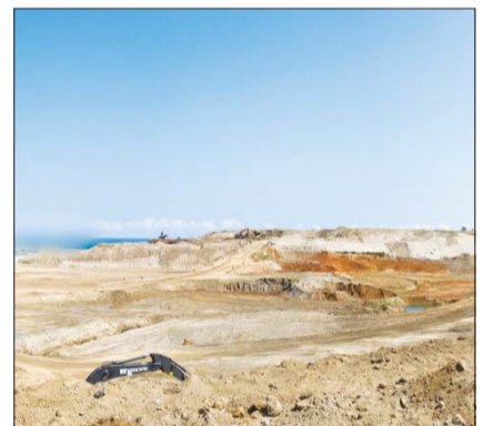
신한울3,4호기 건설공사 부지. /한국수력원자력
