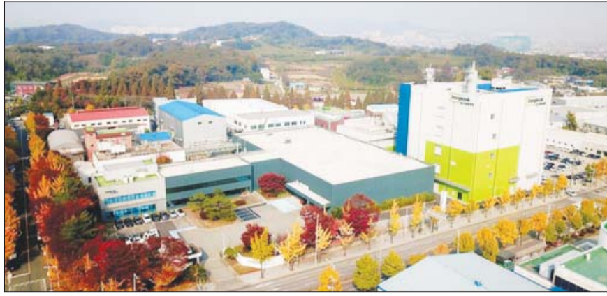
동국생명과학 안성공장 전경.
