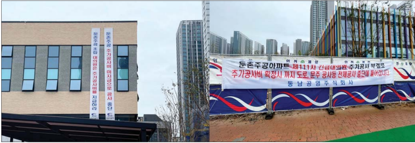
서울 강동구 올림픽파크포레온 현장에 공사 중단을 알리는 현수막이 붙어있다.
