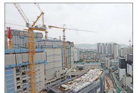
서울 시내 한 아파트 공사 현장에 타워크레인이 설치돼있는 모습.
