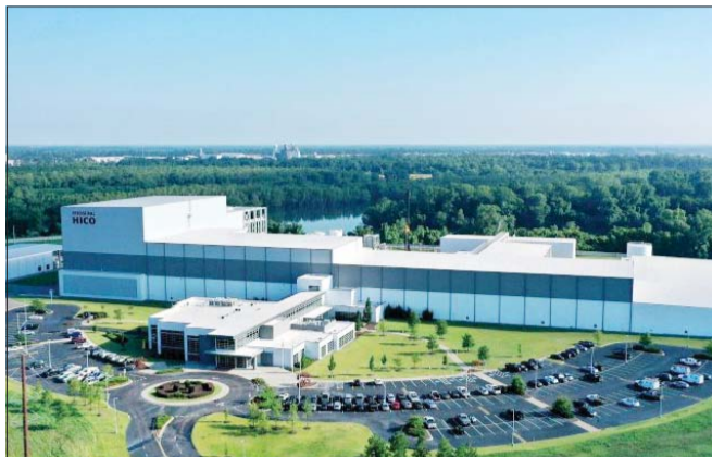
효성중공업 미국 테네시 펠피스 초고압변압기 공장 전경.
