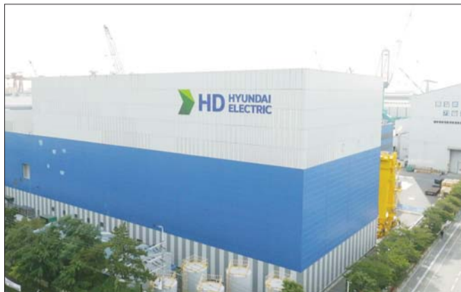
HD현대일렉트릭 변압기 스마트 공장 외경
