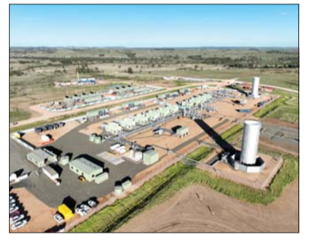
세넥스에너지의 아틀라스 가스전 가스처리시설
