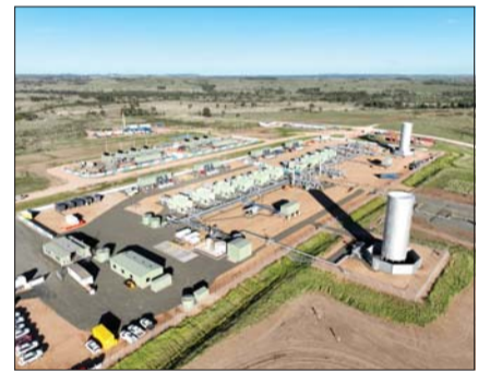
세넥스에너지의 아틀라스 가스전 가스처리시설
