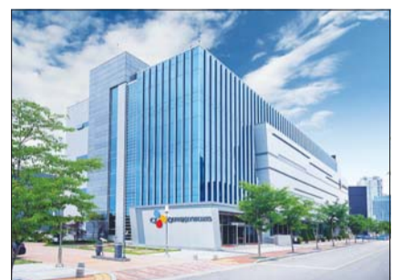
인천 송도에 위치한 CJ올리브네트웍스의 클라우드센터 전경. /CJ올리브네트웍스
