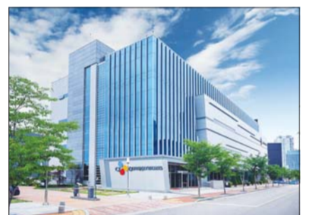
인천 송도에 위치한 CJ올리브네트웍스의 클라우드센터 전경. /CJ올리브네트웍스
