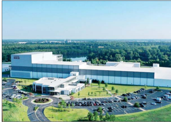
효성중공업 미국 테네시 멤피스 초고압변압기 공장 전경.
