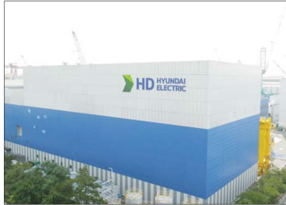
HD현대일렉트릭 변압기 스마트 공장 외경
