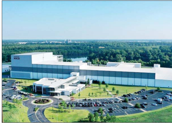
효성중공업 미국 테네시 멤피스 초고압변압기 공장 전경.
