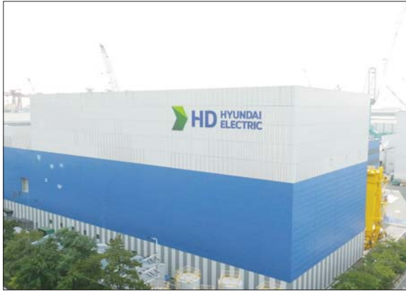
HD현대일렉트릭 변압기 스마트 공장 외경
