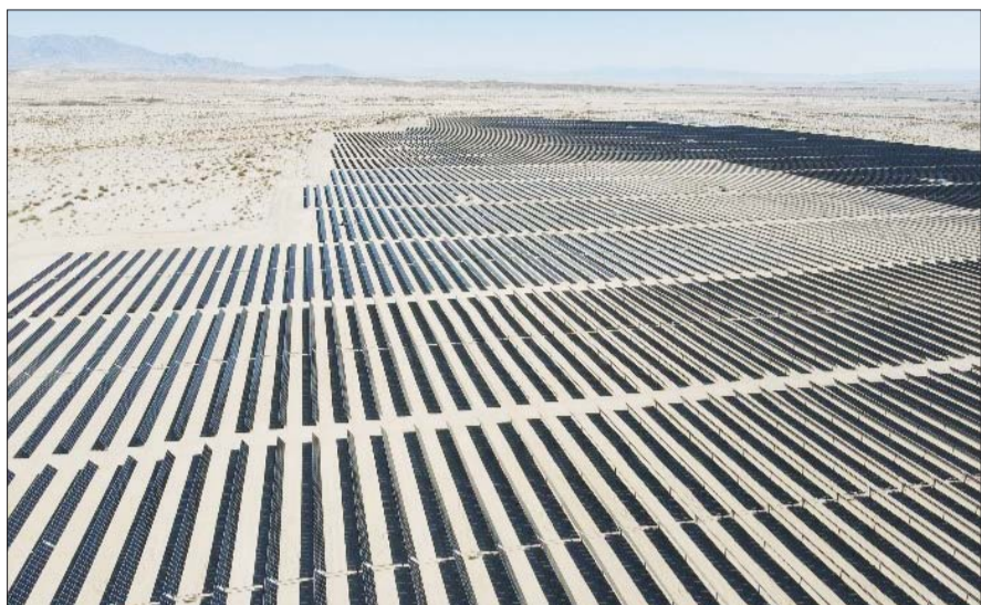
한화큐셀이 완공한 미국 캘리포니아 주 소재 태양광 발전소(50MW). /한화솔루션
