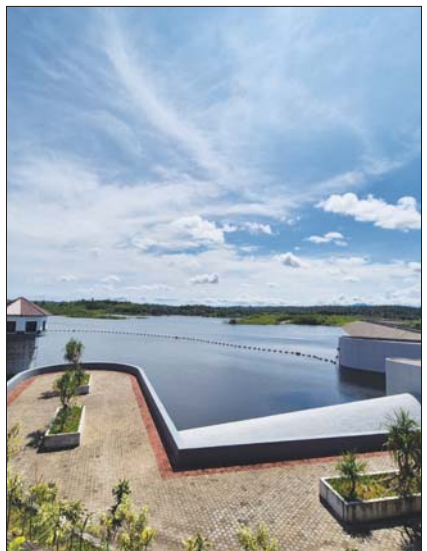
인도네시아 자카르타 반텐주 지역에 위치한 까리안 다목적댐 전경. /김대환 기자
