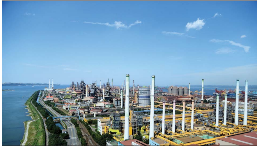
포스코 포항제철소 전경
