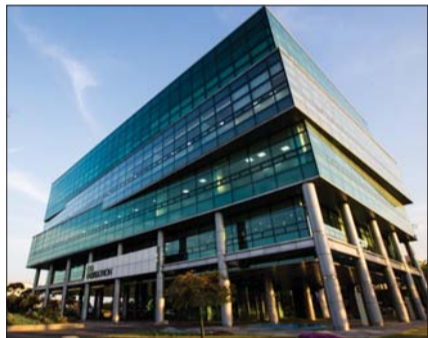
셀트리온 사무동 전경
