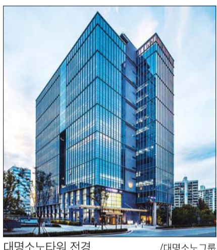
대명소노타워 전경. /대명소노그룹
